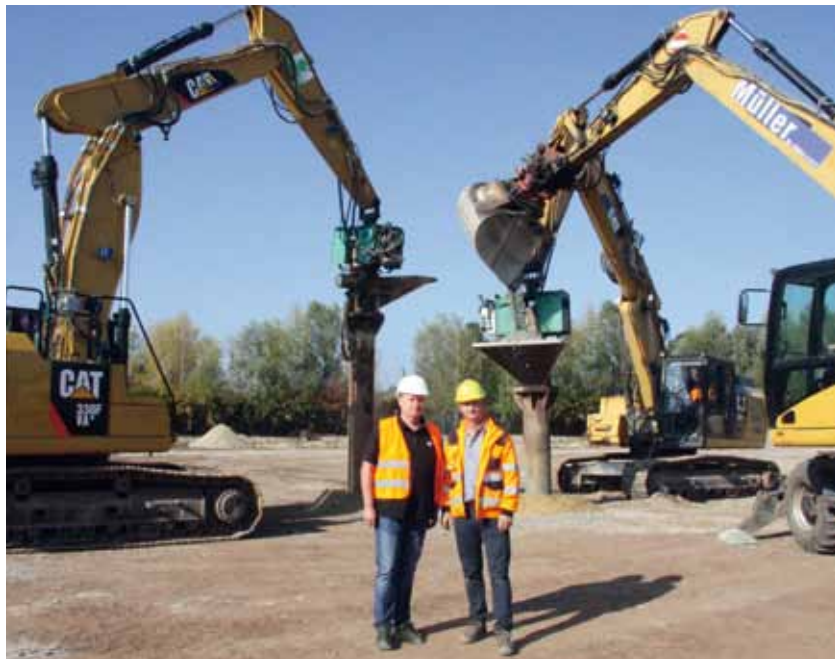
Baustellentermin vor Ort mit Olaf Kloppe (rechts), Geschäftsbereichsleiter Spezialleistungen bei EcoSoil Ost, und Thomas Köppen (links), leitender Zeppelin Verkaufsrepräsentant.
